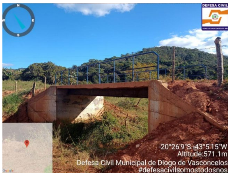
Figura 28. Vista da ponte de concreto - Comunidade Mendes (Foto: Prefeitura de Diogo de Vasconcelos/ Defesa Civil).
