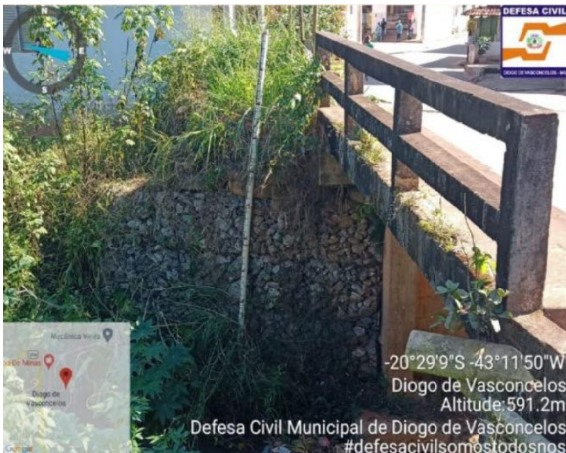
Figura 30. Vista do gabião - Ponte da Liberdade (Foto: Prefeitura de Diogo de Vasconcelos/ Defesa Civil).
