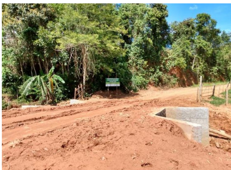
Figura 29. Vista do bueiro duplo - Comunidade Derrubada (Foto: Prefeitura de Diogo de Vasconcelos/ Defesa Civil).
